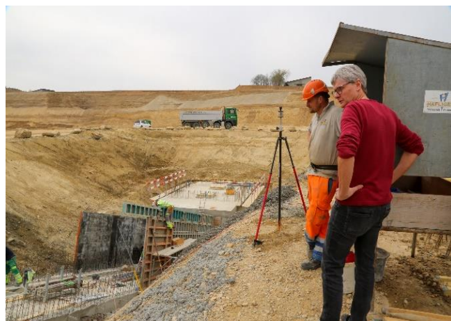
Die Bauarbeiten der Häfliger Bau AG laufen nach Plan. Polier Jonas Graber im Gespräch mit Kurt Marti-Wechsler.
