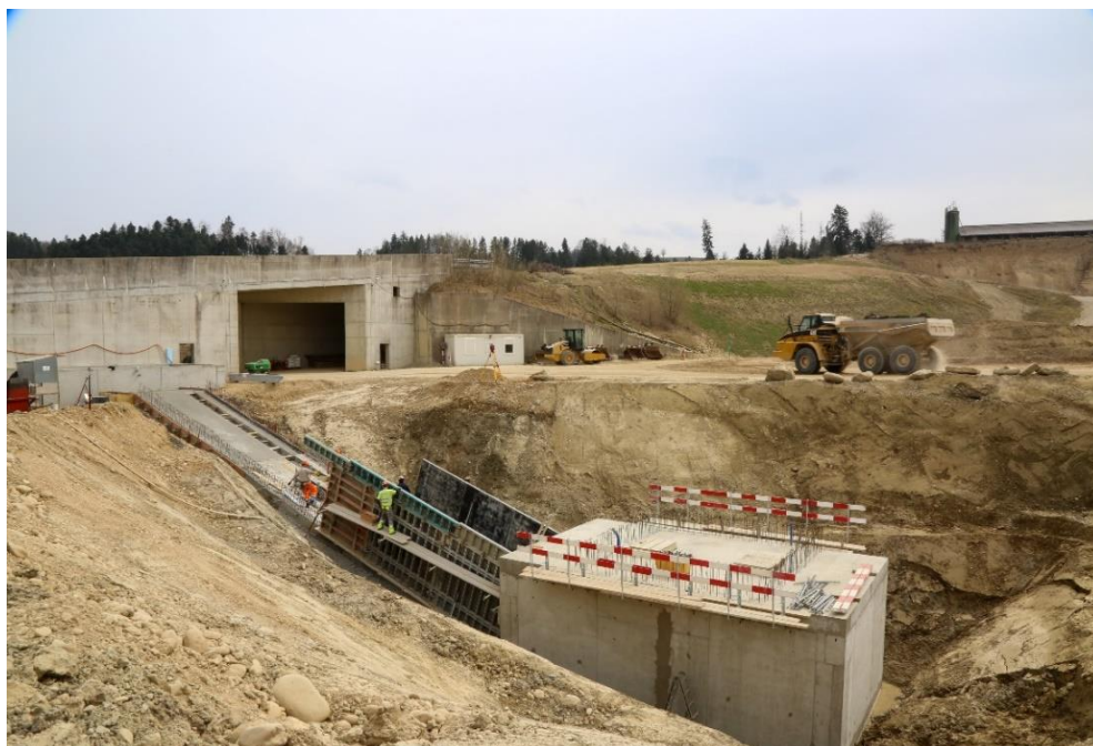
Neun Meter unter der Erde: Bau der neuen Abgabestation für den unterirdischen Transport des Kieses. Nach Fertigstellung ist davon nichts mehr zu sehen.
