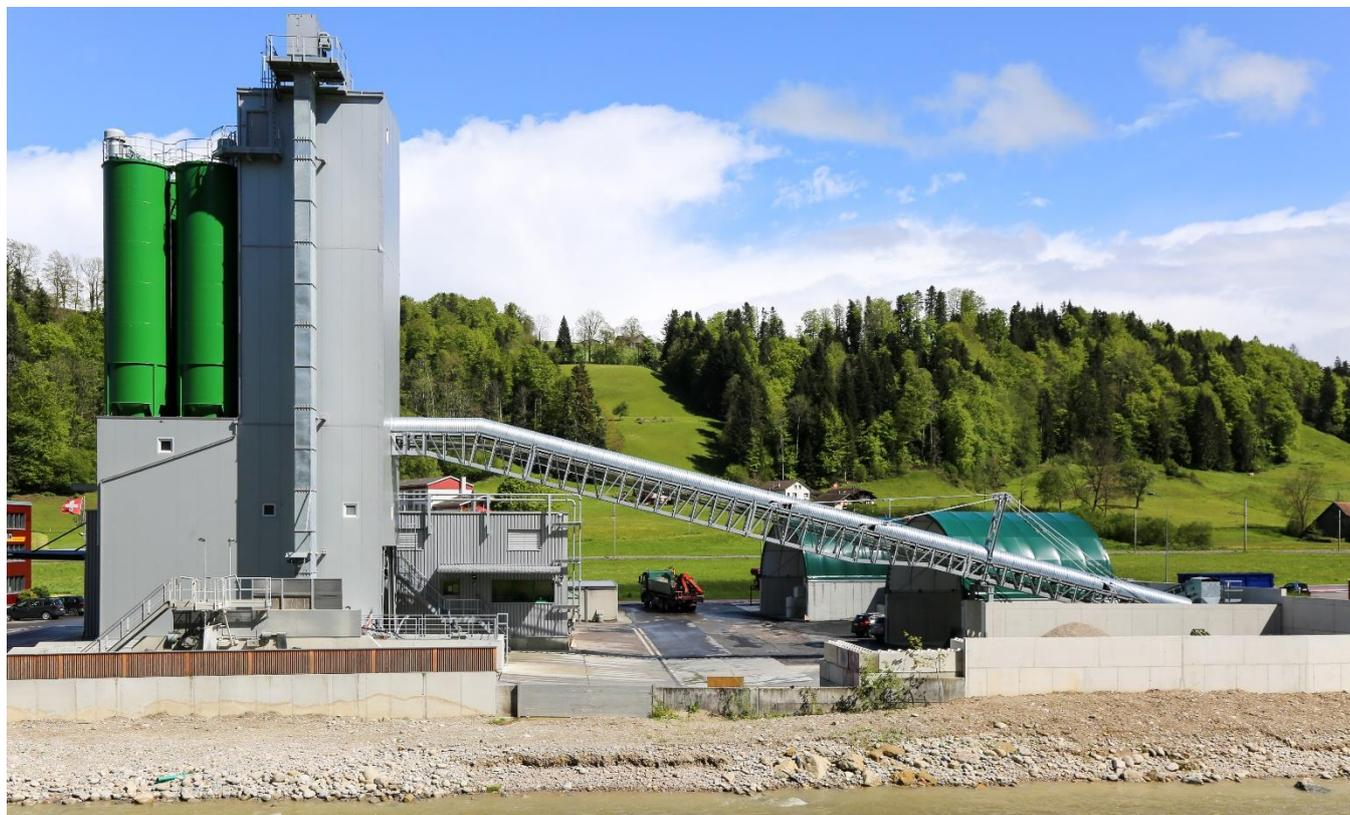
Über das Förderband (rechts) kann der Produktion jetzt auch rezyklierter Beton zugeführt werden. Damit ist die Erneuerung des Betonwerks in Wolhusen abgeschlossen.
