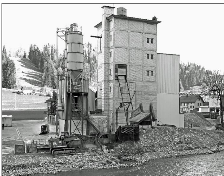
Die heutigen Anlagen werden zurückgebaut.
