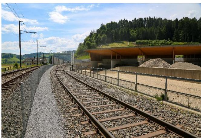
Mit dem Ausbauprojekt wurde die **Logistik für Bahn und Strasse** deutlich verbessert. Der verlängerte MAKIES-Gleisanschluss erlaubt, noch mehr Güter auf der Schiene zu transportieren. Um die Sicherheit zu erhöhen, wurde für LKWs auf dem Betriebsareal der Einbahnverkehr eingeführt – inklusive neuer, interner Brücke.
