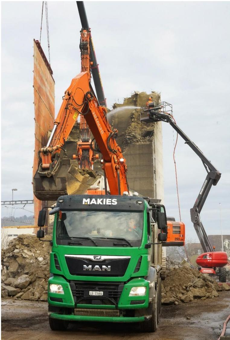
Meter um Meter frassen sich die Abbruchzangen in den Beton des Landiturms, bis er nach rund zwei Wochen Schwerstarbeit Geschichte war. Der hochwertige Rohstoff Beton ist jedoch nicht verloren, sondern wird im Sinne der Kreislaufwirtschaft rezykliert.
